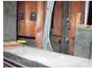
Elemento S01 - Tirante ligneo fissato con staffe a C con affiancato tirante metallico, probabilmente inserito prima metà sec. XX (forse 1909).
