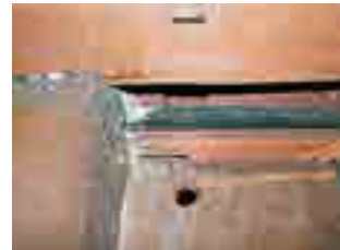
Elemento S03 - Piatto metallico altezza 100 mm, inserito probabilmente prima metà sec. XX (forse 1909), particolare dell'aggancio con la muratura.
