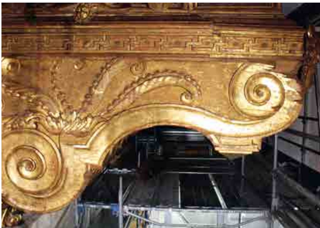
Fig. 8. Intervento di stuccatura e ritocco, mensolone di sinistra.
