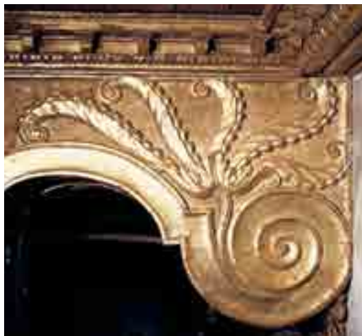
Fig. 6. Particolare di un mensolone a restauro ultimato.
