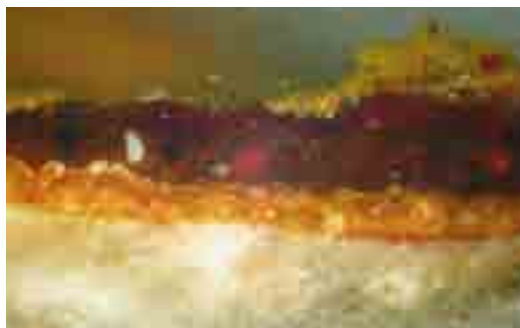
Fig. 11. Sezione stratigrafica del campione prelevato dalla scanalatura dove risulta evidente la presenza di numerosi interventi di manutenzione.
