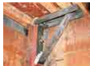
Elemento S04 - Staffa metallica a sostegno della colonna destra, inserita probabilmente prima metà sec. XX (forse 1909).
