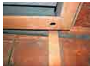
Elemento S03 - Piatto metallico altezza 100 mm, inserito probabilmente prima metà sec. XX (forse 1909), particolare passaggio dietro il pilastrino di supporto.
