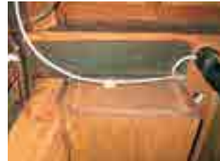
Elemento S02 - Profilo metallico angolare 100x100 mm inserito, probabilmente prima metà sec. XX (forse 1909), a supporto della trave passante che sostiene le canne.
