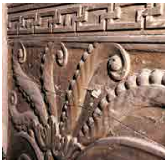
Fig. 4. Particolare di un mensolone del sopbalco prima dell'intervento di restauro.
